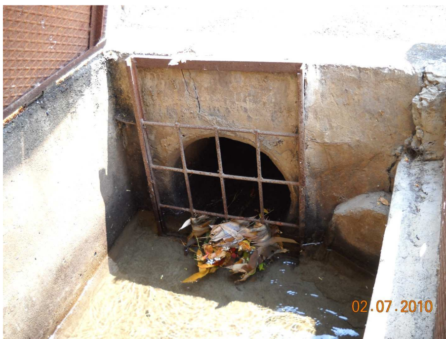
Foto 2: Vaso Re di fronte al comune. Nel caso di eventi significativi, con notevole trasporto solido da monte, la griglia posta a monte del tratto coperto, tende ad intasarsi.
